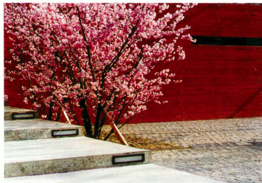
ressants entre la cour et la rue. La surface du mur, comme «fossile» et au touché remarquable a été obtenue grâce à un coffrage en bois brut.
