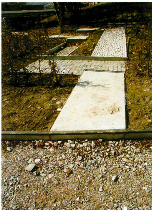
Der Gehgarten im Bau
