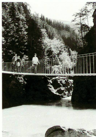
Die Pünt da Suransuns von Ingenieur Jürg Conzett wurde im Sommer 1999 gebaut. Die filigrane Brücke mit Andeerergranit setzt einen zeitgenössischen Akzent. Dank diesem Übergang im Südteil der Schlucht ist die Viamala für Fussgänger nun durchgehend begehbar.
