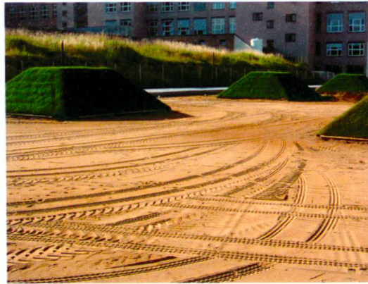
Aufbau der Pyramiden vom Rohbau zur Begrünung.
