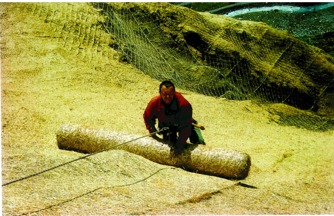
Verlegen einer Beschattungsmatte im Steilbereich des Böschungskopfes mit Seilsicherung.
