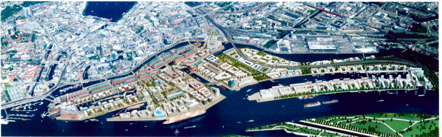
A. Schiebel, Quelle HafenCity Hamburg GmbH
