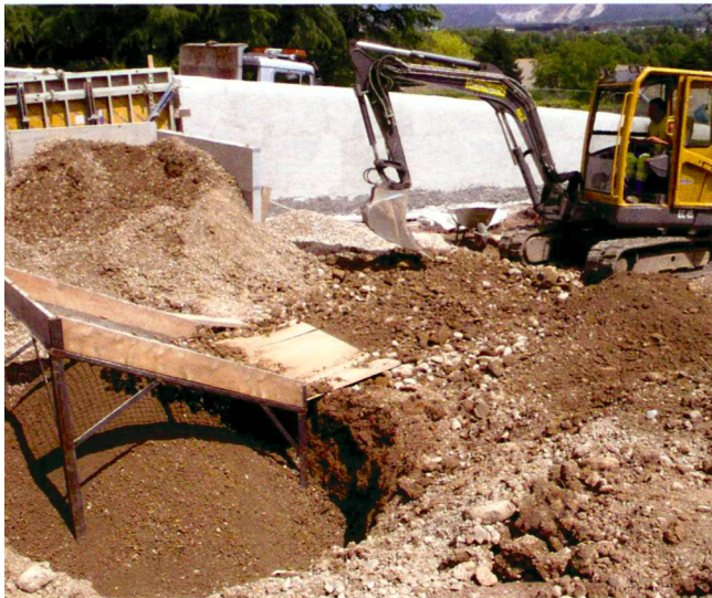
Der gesiebte Lehm wird mit Kies gemischt. Terre tamisée puis mélangée à du gravier.
