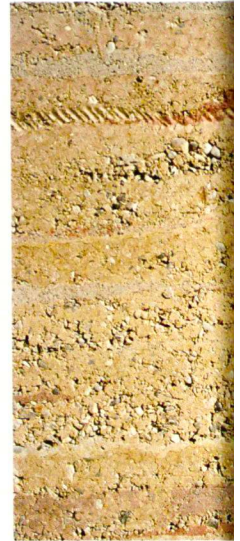
Oberflächentextur. Texture du mur en terre.
