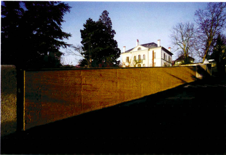
Wieder hergestellte Mauer. Réhabilitation des murs.
