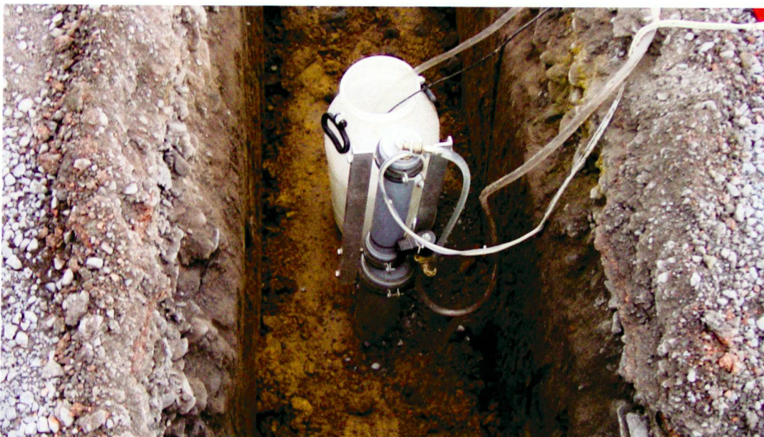
Bestimmung der Wasserdurchlässigkeit nach dem Open-End-Verfahren.
