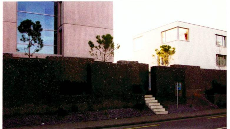
facher ist. Aus statischen Überlegungen ist in solchen Fällen statt mit einem Anzug besser mit Rückversatz zu arbeiten. Kurven und Winkel sind mit vorverfüllten Körben nur bedingt möglich. Bei Richtungsänderungen entstehen zwangsläufig keilförmige Fugen.
