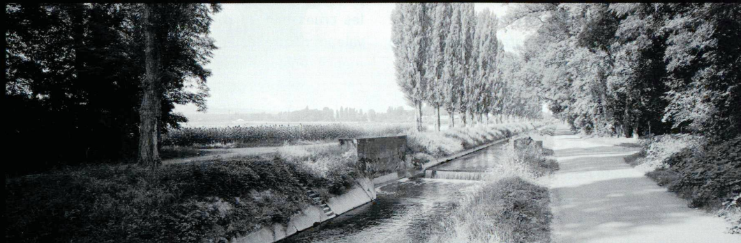
1 Der bestehende Kanal unterhalb von Lully. Le canal existant à l'aval de Lully.
