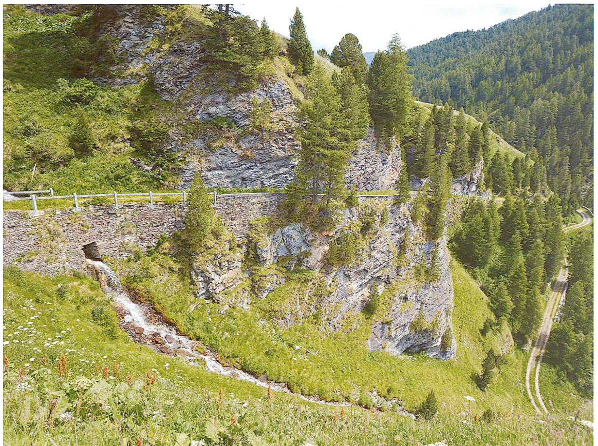
1 Alte Averserstrasse von 1890–1895 unterhalb von Cresta GR. L'ancienne route Averserstrasse, 1890–1895, en dessous de Cresta GR.
