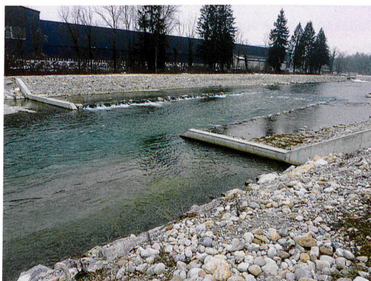
2 Halbrampe an der Emme in Biberist, Kanton Solothurn, 2013. Demi-rampe sur l'Emme à Biberist, canton de Soleure, 2013.
