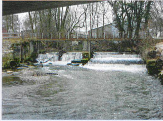
Ehemaliges Wehr mit Mittelpfeiler und Fussgängersteg, 2009.
