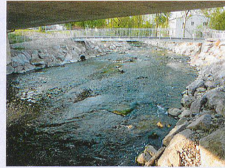
Blockrampe mit neuer Fussgänger- und Velobrücke, 2011.
