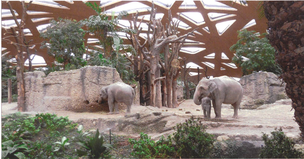
Umweltechnik und Bewässerung des Elefantenparks Zoo Zürich
