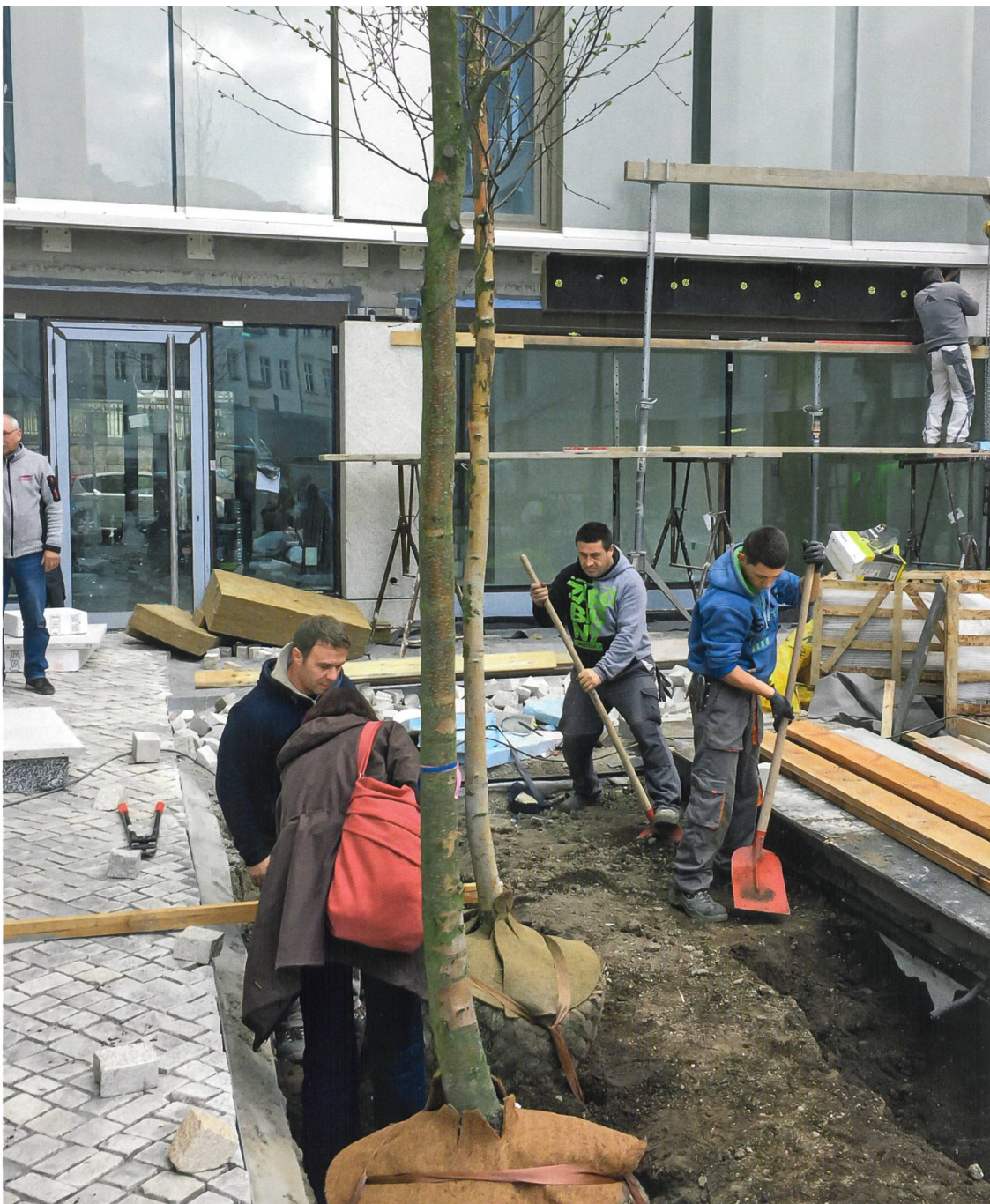
3 Anweisungen für die Baumpflanzung auf einer Tiefgarage – anpacken wird immer geschätzt! Préconisations pour la plantation d'arbres sur un garage: mettre la main à la pâte est toujours apprécié!
