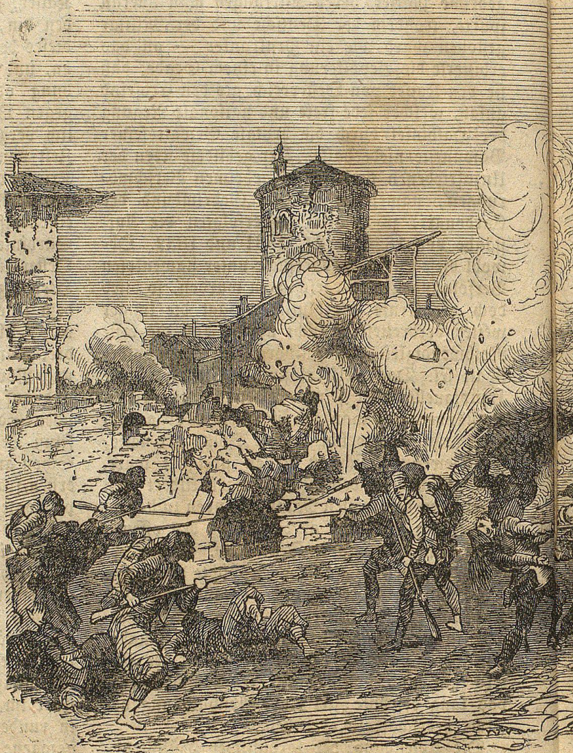
Sprengung der Brücke
