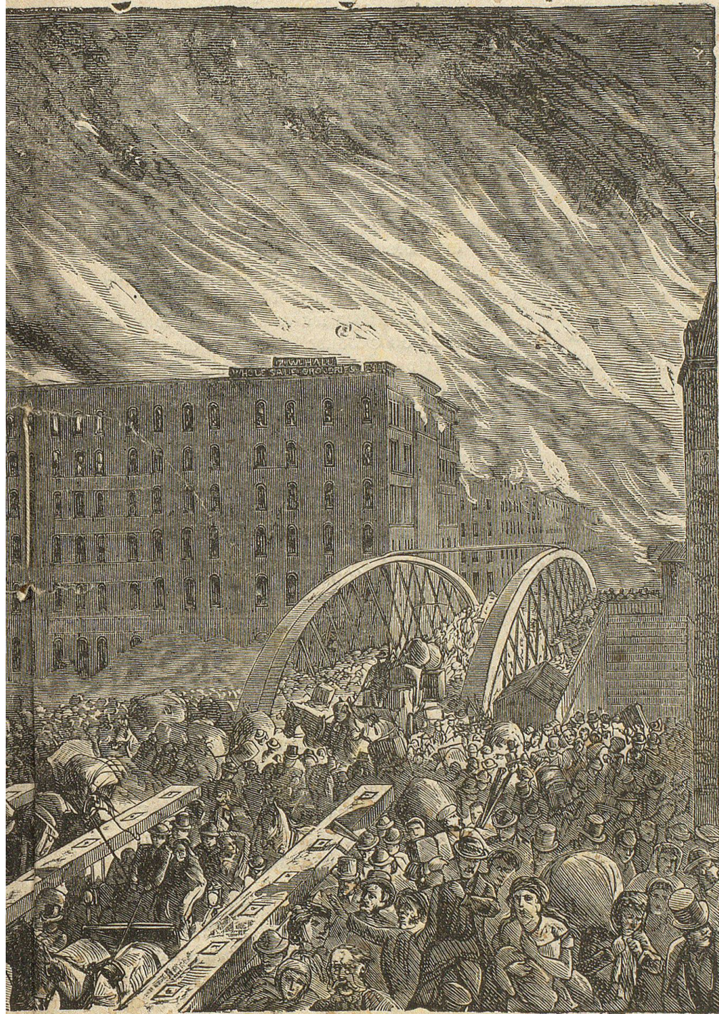
Wohnner über die Brücke der Randolphstraße.
