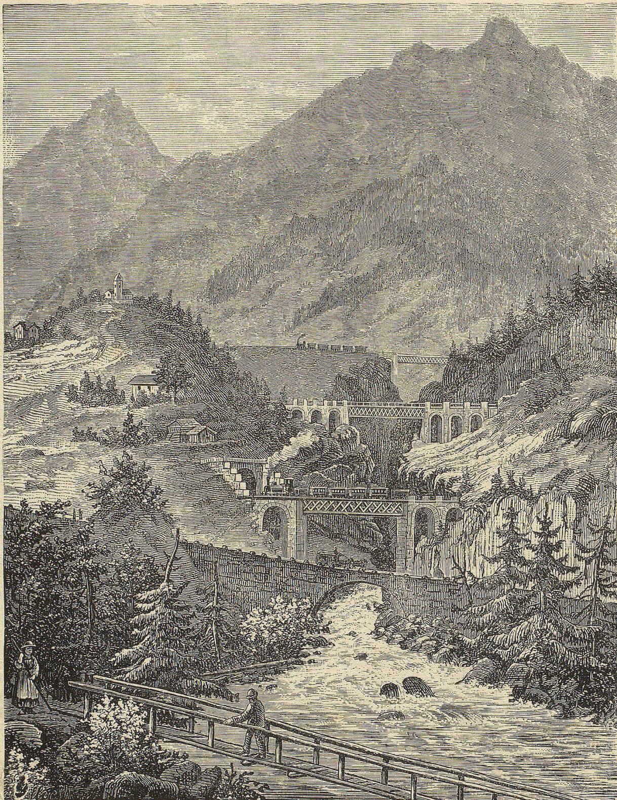
Die Brücken über die Matenreuz bei Wasen.
