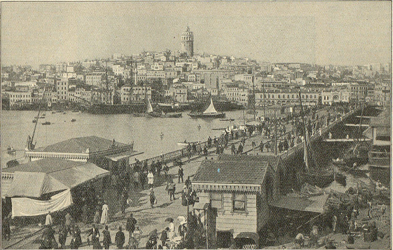
Untere Brücke über das Goldene Horn von Stambul nach Galata, früher von hölzernen Pontons getragen.
