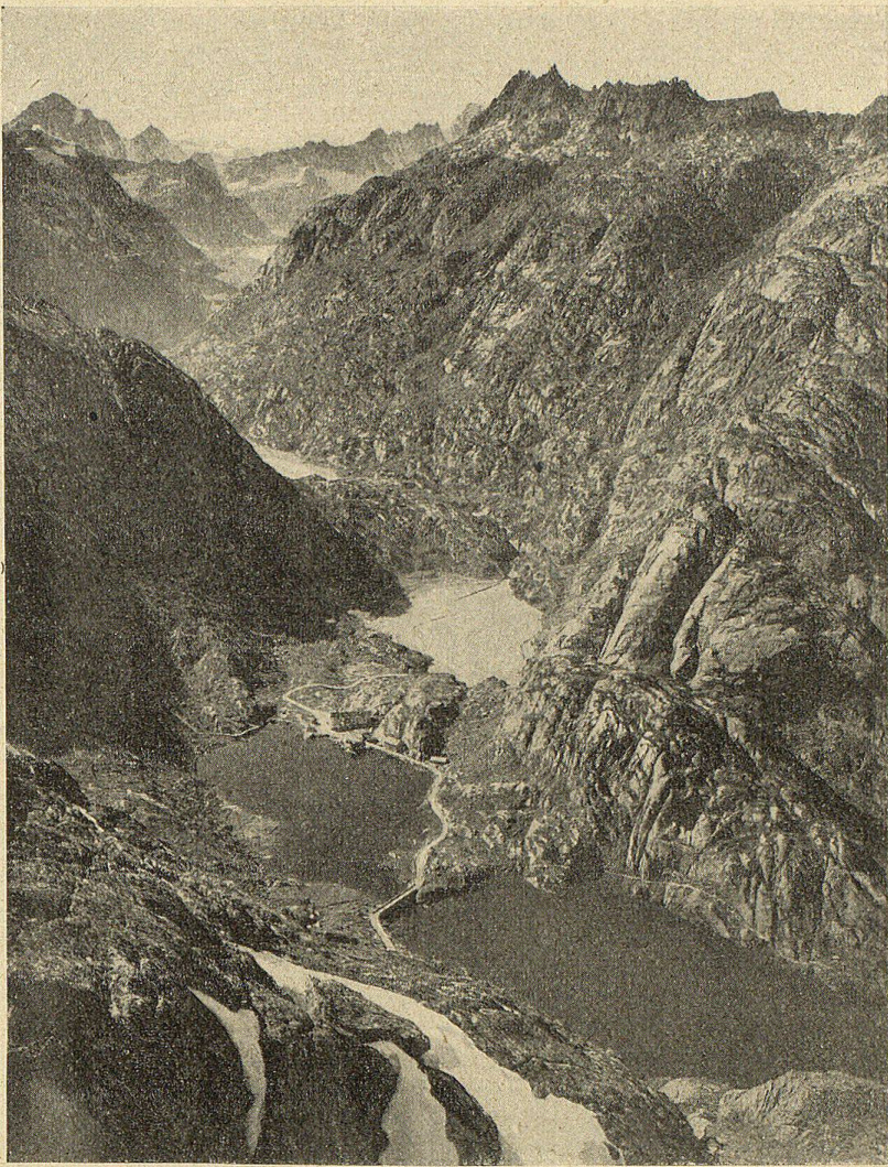
Niederblick von Nägeligrätli auf die Grimselsee, das Hospiz und das Ober-Martal, die zusammen in einen großen Stausee für die Hasle-Kraftwerke bei Innerkirchen umgewandelt werden sollen.
