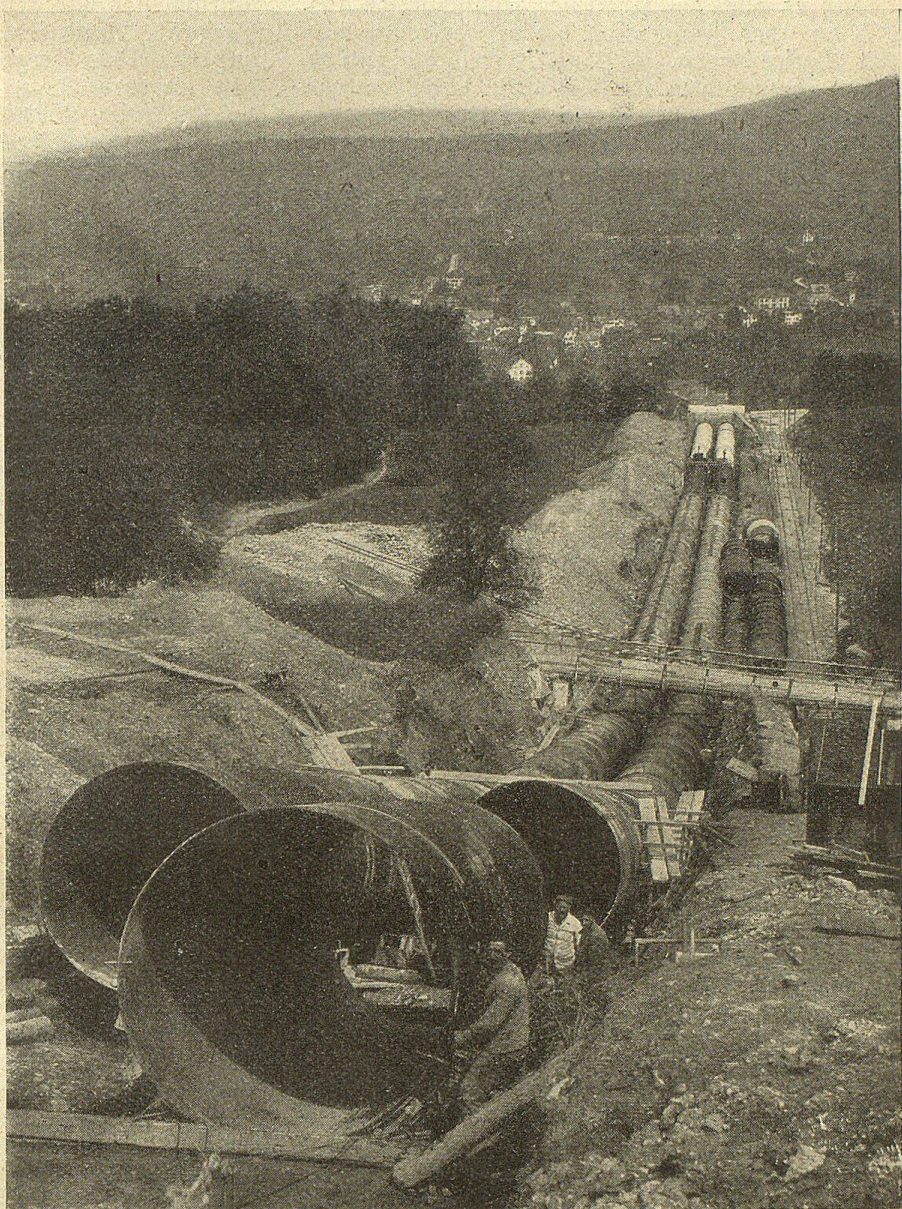
Druckleitung Siebren; Verlegen der Rohre im Graben.
