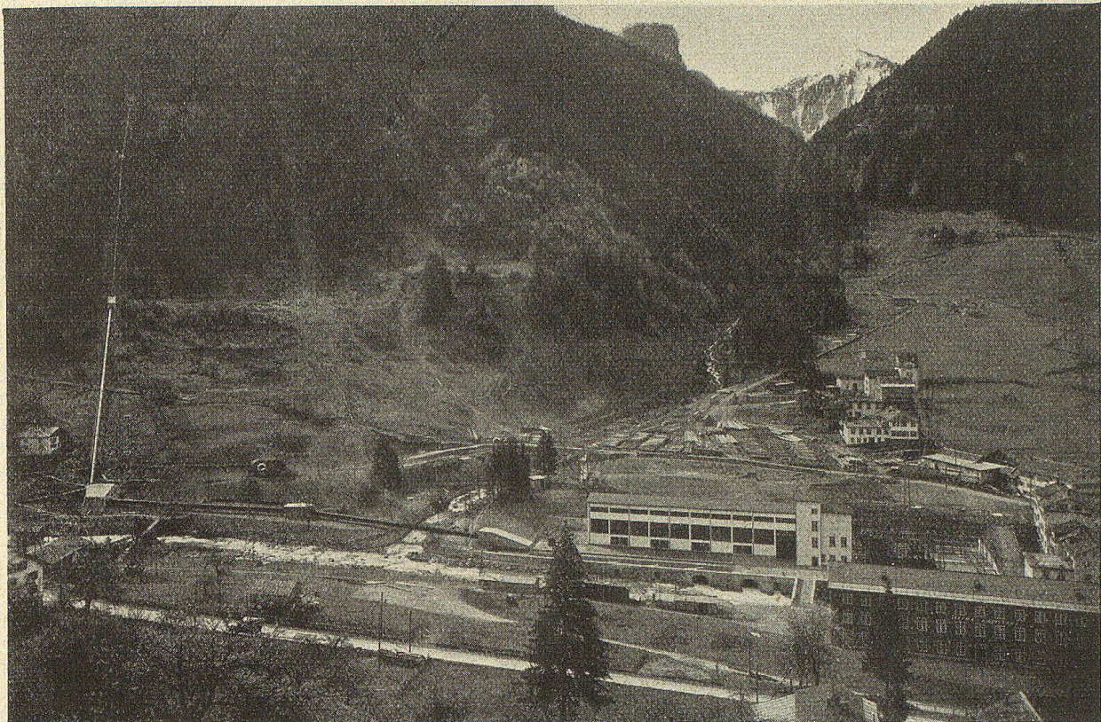
S. N.-Zentrale in Schwanden bei der Mündung des Niederenbaches in die Sernf. Links die Druckleitungen des Sernfwerkes und des Niederenbachwerkes. Rechts Freiluftstation mit abgehender Hochspannungsleitung.
