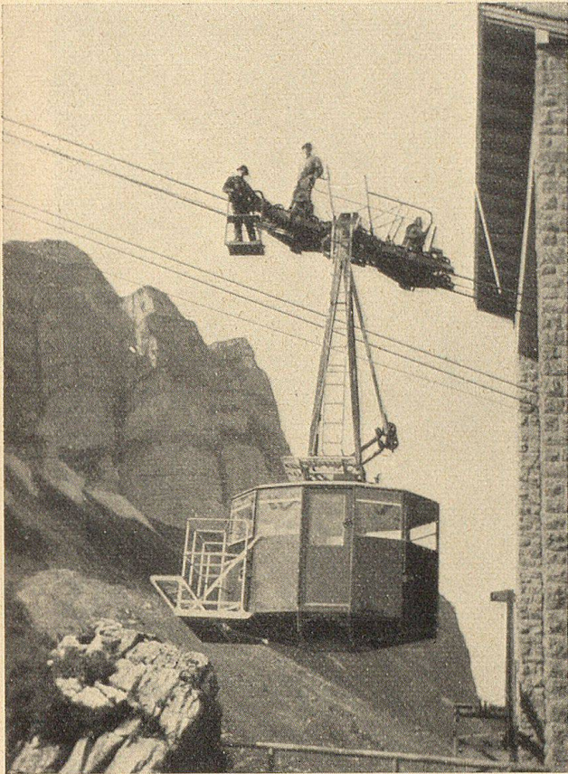
Eine der beiden Kabinen bei der Ausfahrt von der Talstation Schwägälp. Jede Kabine faßt 35 Personen. (Phot. Geuß, Urnäsch).
