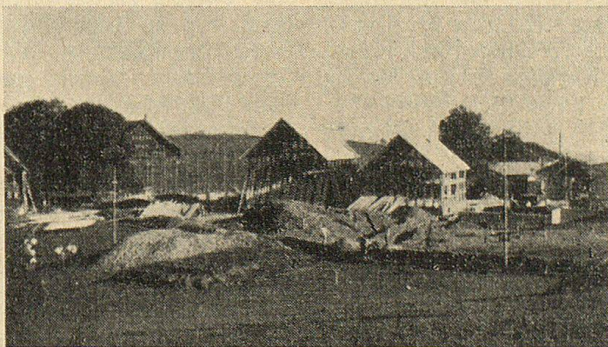
Stand der Bauarbeiten Ende Juli 1946
