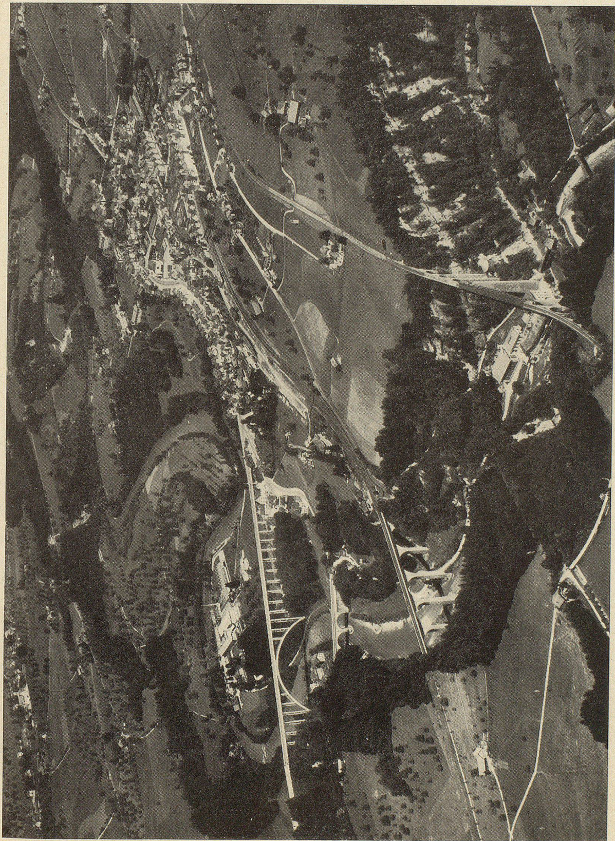
Übersicht über das Brückenmuseum im Sittertobel. Links oben die neue Fürstenlandbrücke, unten die alte steinerne Kräzerbrücke, dann das Eisenbahnviadukt der SBB, dasjenige der Bodensee-Toggenburg-Bahn und unmittelbar rechts davon die beiden alten Hüslibrücken, über die sich einst der ganze Verkehr abwickelte. (Fliegeraufnahme Hans Groß — Aero St. Gallen.)
