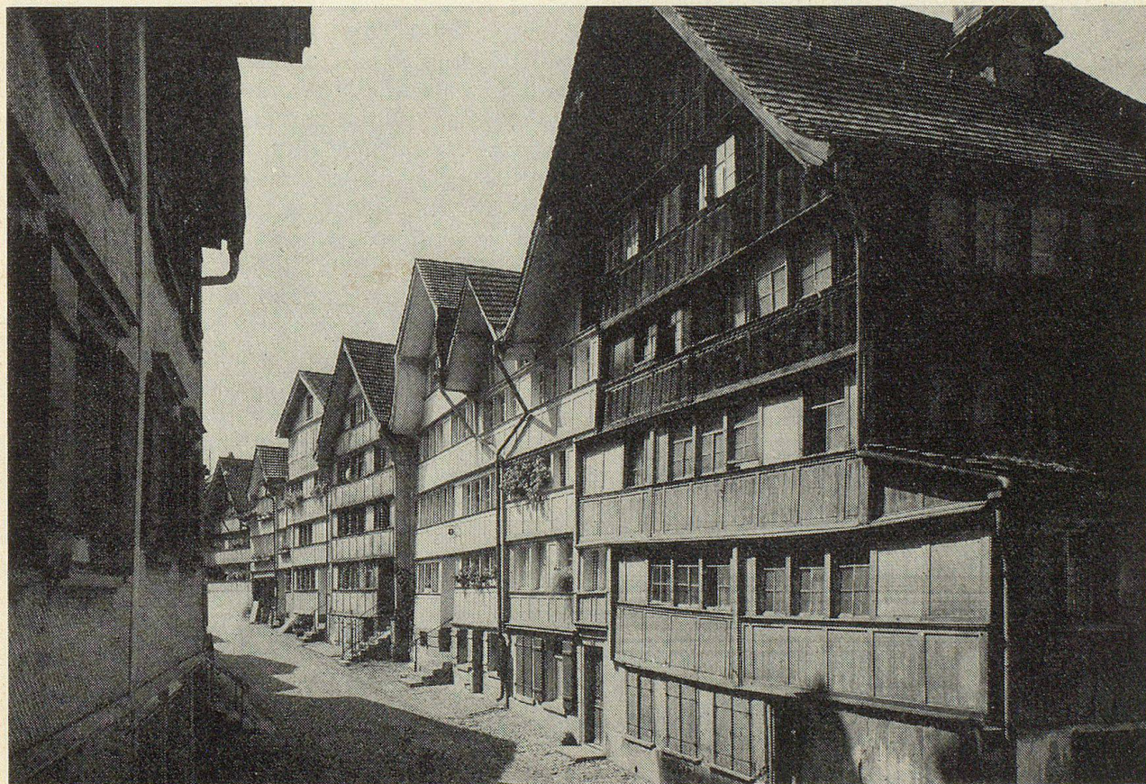
Herisau. Äussere Schmiedgasse. Erste Reihe rechts (Nummern 32—44 der geraden Zahlen) gestricke und an der Front getäfelte Holzhäuser wohl hauptsächlich des 18. Jahrhunderts.
