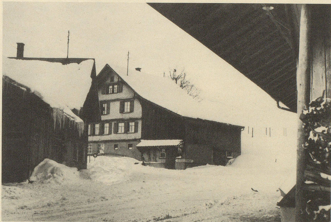
Auch der geschlossene Weiler Rotbühl (Fischingen) ist gefährdet, weil für den Strassenbau eine Platzwand abgebrochen werden soll. Foto Archiv Denkmalpflege
