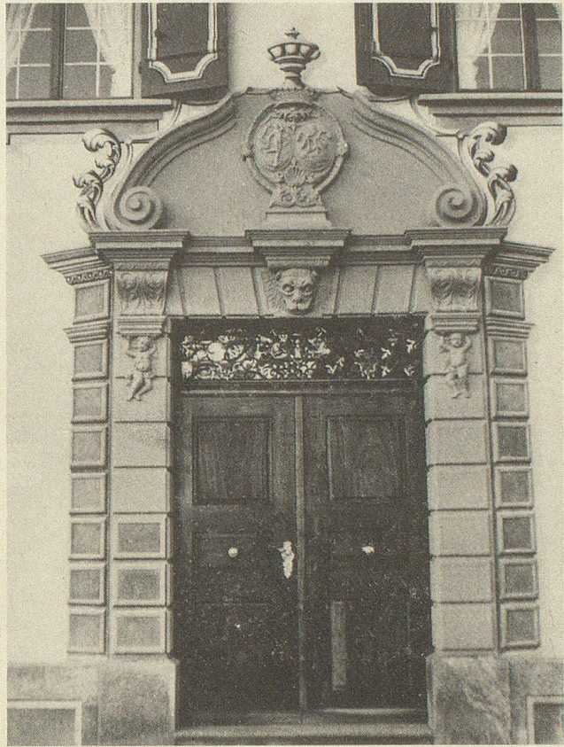
Frontportal des Wetterhauses mit Sandsteingewände und schmiedeisernem Oberlichtgitter
