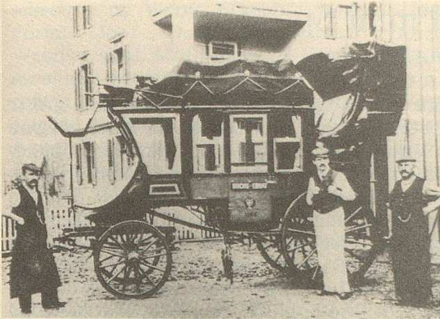
Wagnermeister Jak. Bleiker, Malermeister A. Eschmann und Sattlermeister Eugster freuen sich nach vollbrachter Arbeit an einer renovierten Postkutsche.
