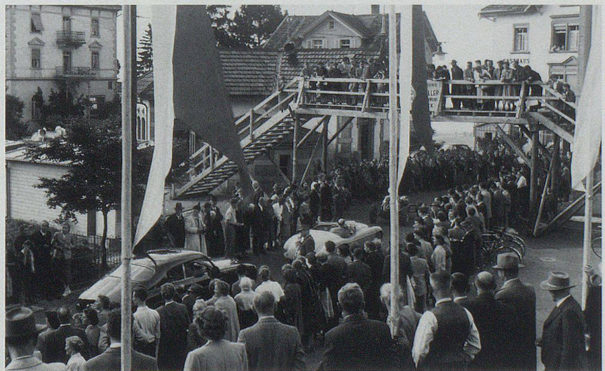
Zu jedem Autorennen gehörte die aus Holz erstellte Fussgängerüberführung, die im Walzenhauser Dorfzentrum während des Rennbetriebs den Zugang zum Bahnhof und zum Hotel Kurhaus-Bad ermöglichte.
