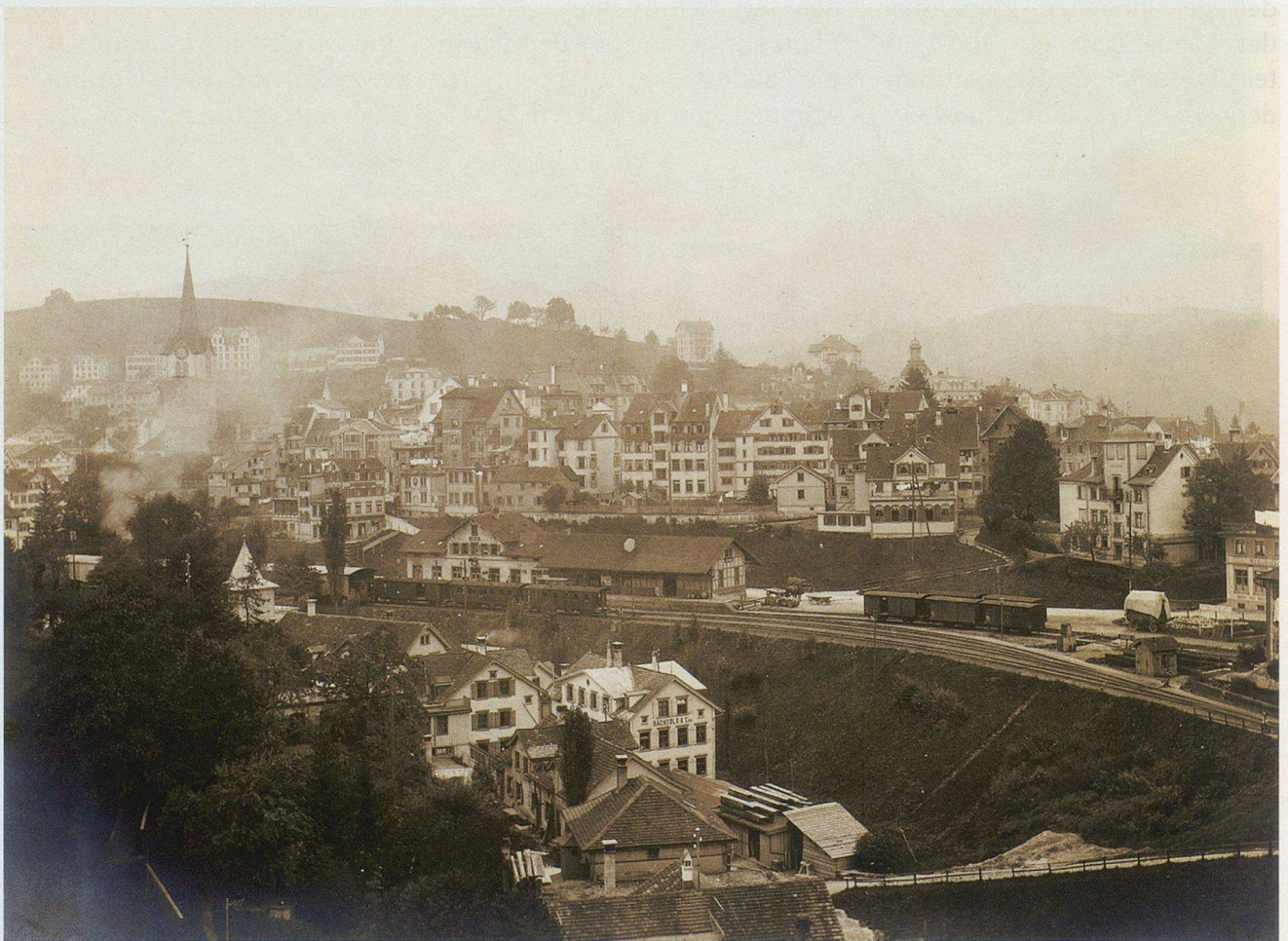
Die Ein- und Ausfahrt in die zentrumsnahe Station Herisau der Appenzeller Bahn geschah über das gleiche, von rechts kommende Gleis. Richtung Urnäsch–Appenzell fahrende Züge wurden zur Abweigstelle zurückgeschoben.
