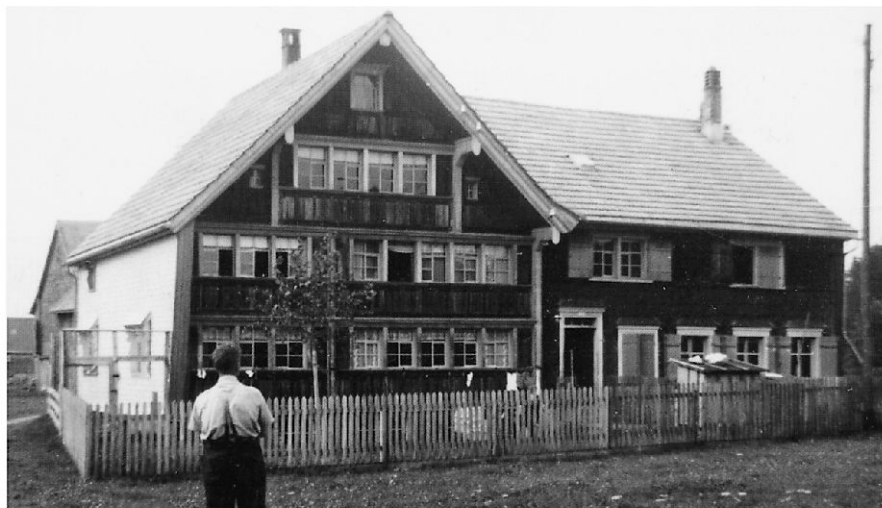
Der Fundort um 1957/58. In diesem Haus gingen im Laufe des 18. und 19. Jahrhunderts 67 Kleinmünzen und 1 Rechenpfennig verloren.
