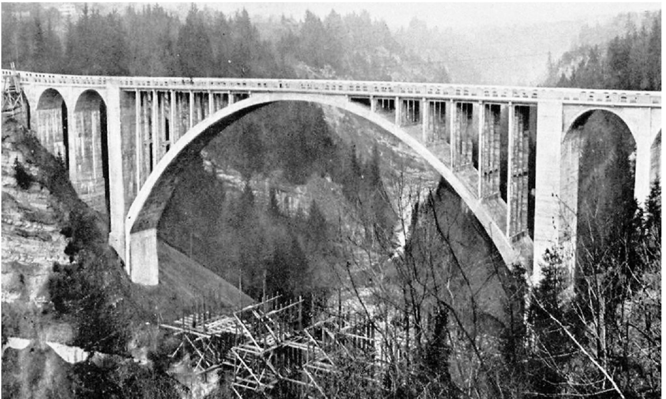
Gesamtansicht der Gmündertobel-Brücke nach der Fertigstellung, November 1908. Bemerkenswert ist auch das sorgfältig gestaltete Gelände aus Beton.
