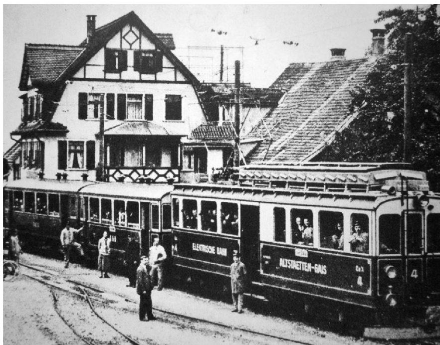
Die Gais-Altstätten-Bahn (hier ein Zug beim Stadtbahnhof in Altstätten) wurde am 17. November 1911 festlich eröffnet.
