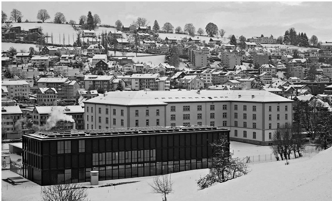
Die Kaserne Herisau erhielt ein neues Theorie- und Verpflegungsgebäude, das denkmalgeschützte Hauptgebäude im Hintergrund wurde umfassend saniert.
