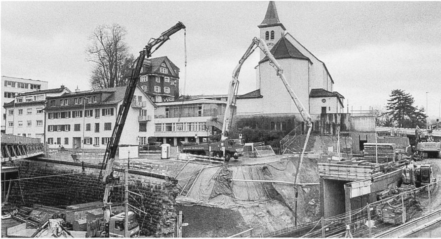
Brückenabbruch an der Bahnhofstrasse in Herisau.
