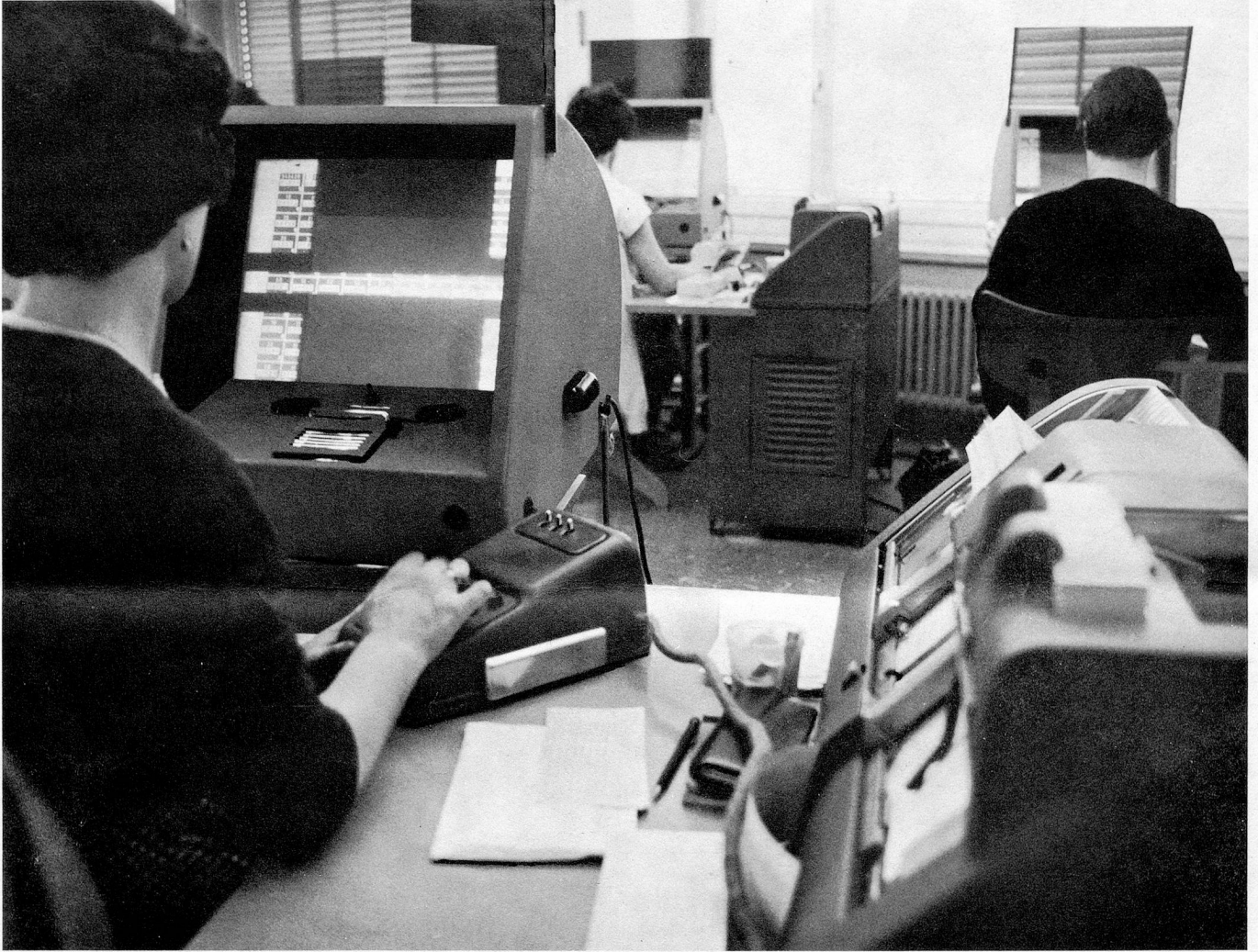
Abb. 2. Uebertragung der Mikrofilmaufnahme der Zählerstände der Telephonabonnenten auf Lochkarten; Lesegerät
