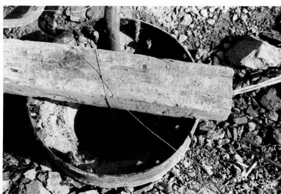
8 — Foto dell'installazione dei sensori in un palo centrifugato a Ennethorw (autostrada N2/6)
