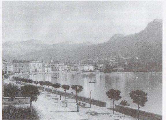
Il tratto di lungolago di Riva Vela appena terminato. Guazzo di Caratti, 1883, Ufficio Tecnico Lugano
