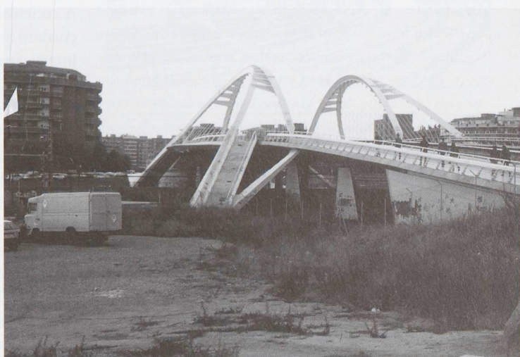
C - Ponte Felipe II Bach de Roda a Barcellona
