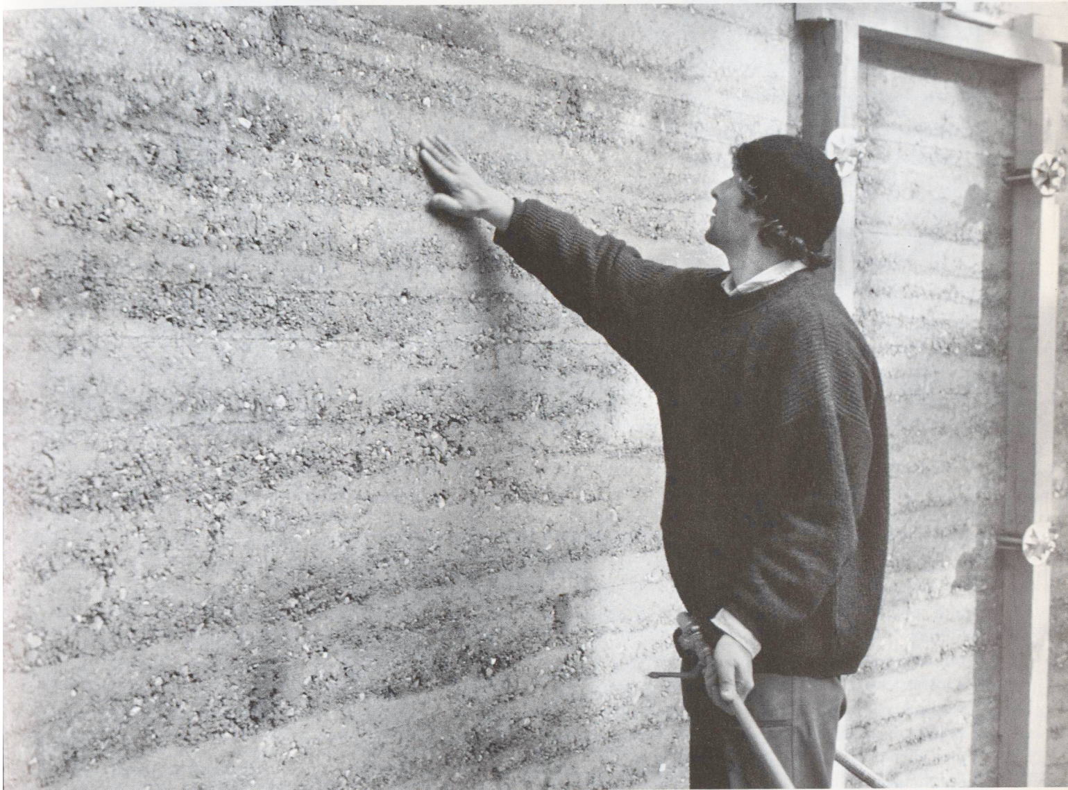
Martin Rauch controlla il muro di terra, che resterà a vista senza intonaco od altre protezioni. Nella texture del muro è possibile riconoscere i frammenti delle macerie dell'antica chiesa abbattuta durante la guerra fredda
