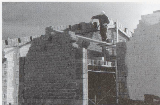
Un momento della realizzazione degli alloggi
