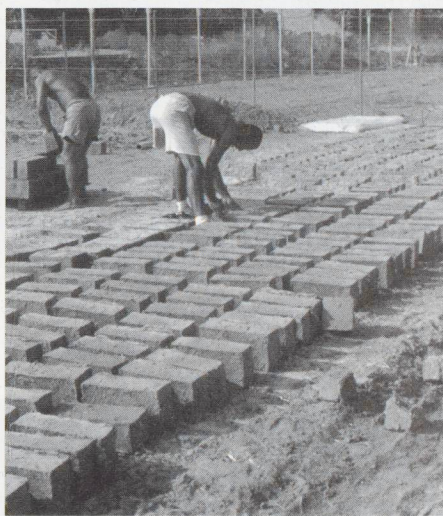
La spicolatura dei mattoni in terra cruda
