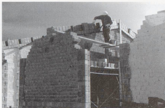
Un momento della realizzazione degli alloggi
