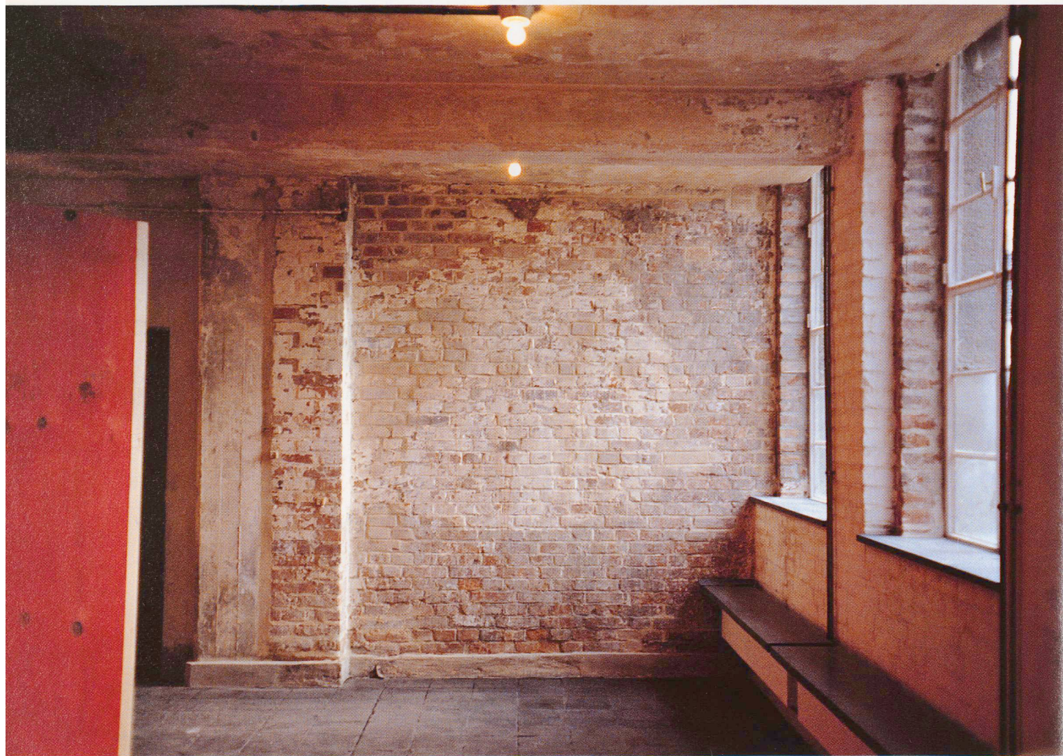
Foto della cantina restaurata secondo lo stato originario del 1926 (edificio mediano)
