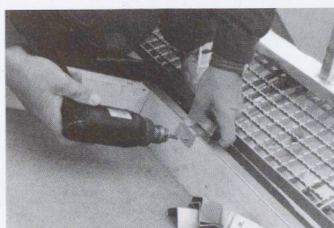
Montaggio dei supporti per il vetro
