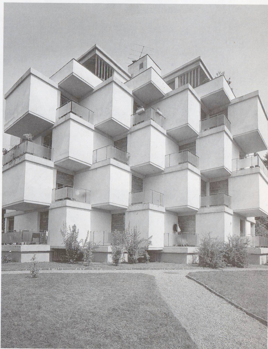
Casa d'appartamenti, Massagno, 1957
