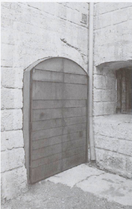
Il nuovo portone di ingresso al Forte (lamiera d'acciaio acidata e profili)
