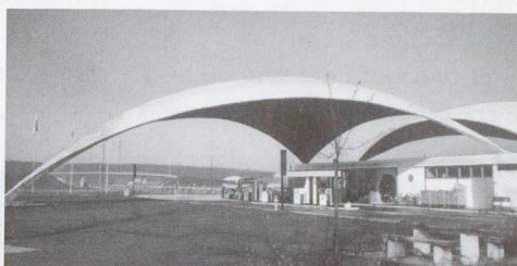
3 – Heinz Isler, Copertura di un distributore di benzina Deitingen
