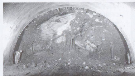
Fronte di scavo in materiale sciolto
