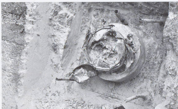
3 – Ancoraggio della prima generazione
