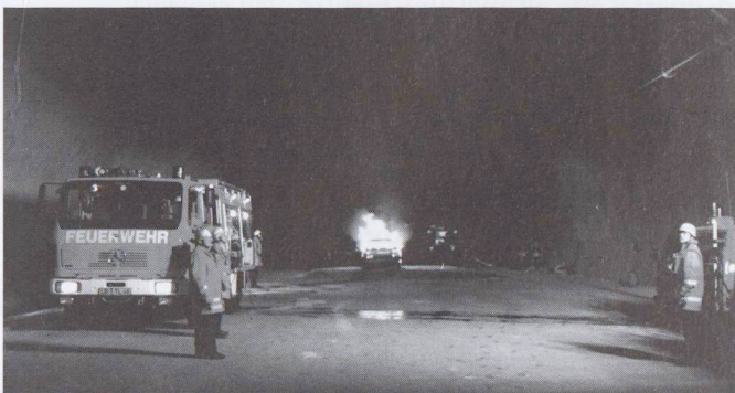
18 - Prove incendio nell'Engelbergtunnel, Stuttgart
