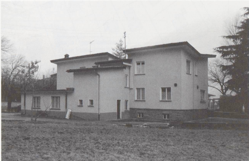
Il fronte posteriore, nella situazione preesistente
